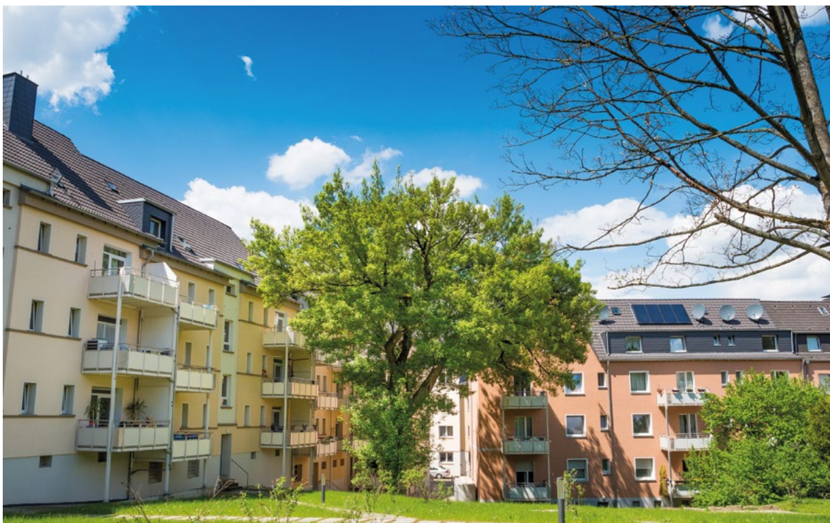
▲ Auch die letzten Innenhöfe der Südosthöfe wurden 2020 fertiggestellt.
