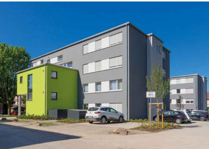
▲ An der Wildstraße baute Allbau 57 öffentlich geförderte Wohnungen.
