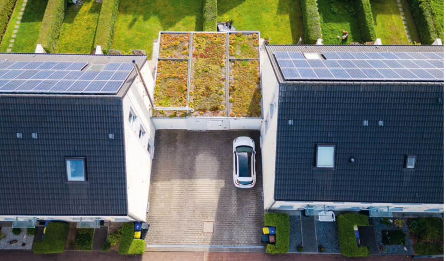
▲ Garagendachbegrünung und Photovoltaik in einem Quartier.
